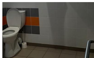
Toilette pour les personnes à mobilité réduite
